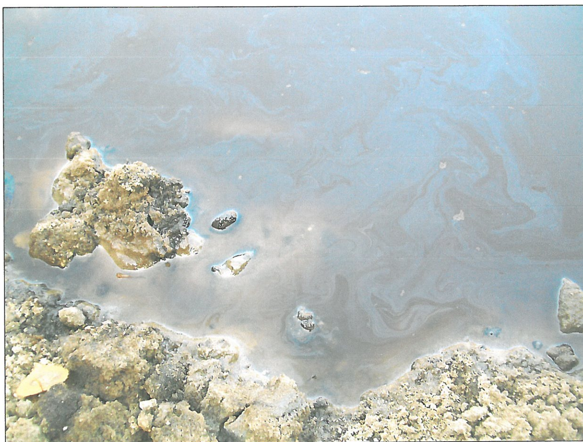
Figure 35 : Irisations à la surface de l'eau en fond de fouille.
