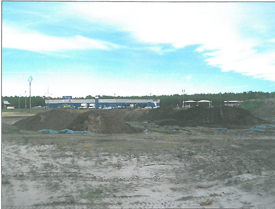
Figure 40 : Stockage des terres polluées.
